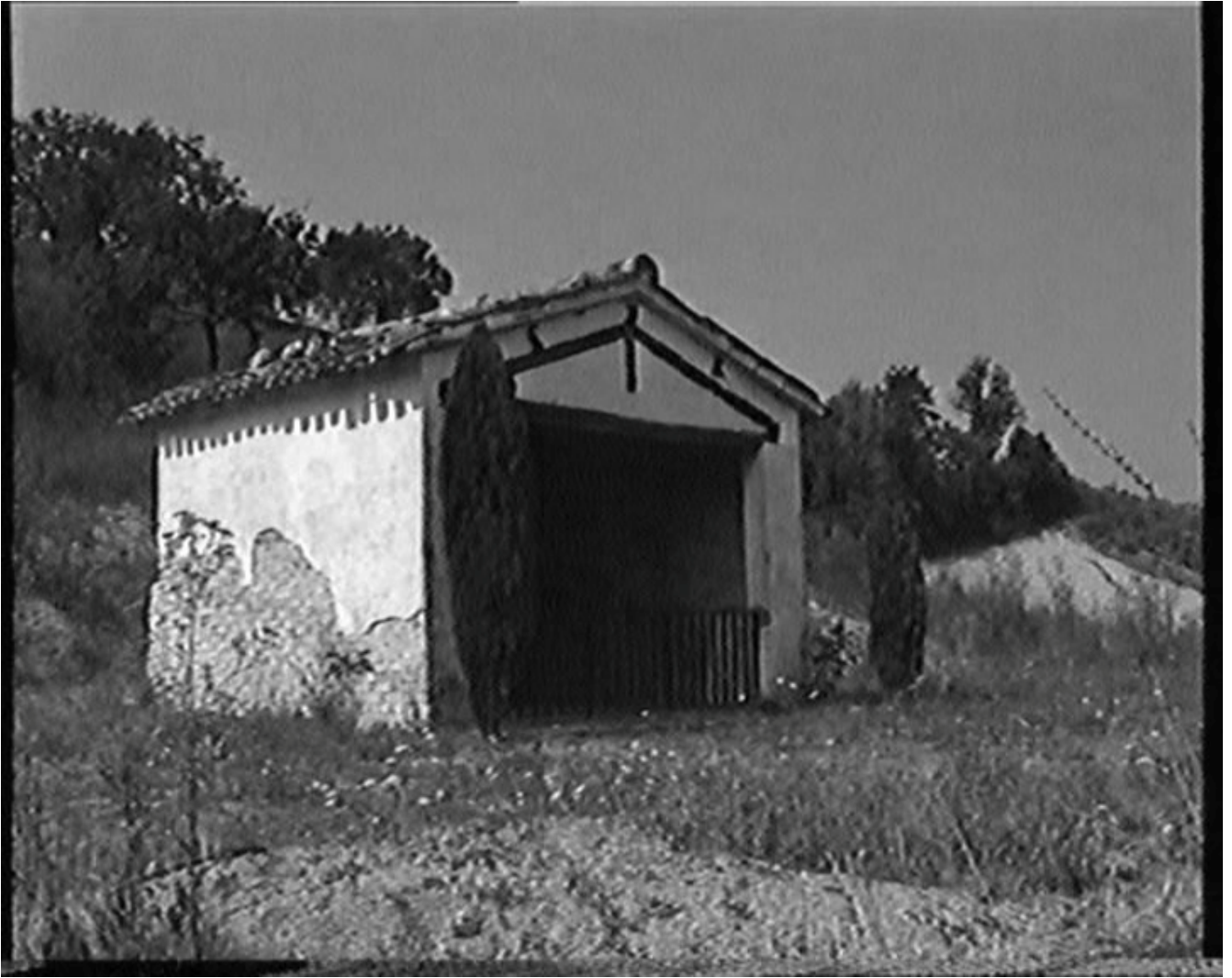
Vallunga -Loggia Baldini dove avvenne l'eccidio
