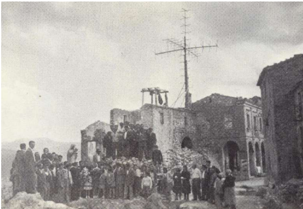
Chiesa di S. Donato distrutta
