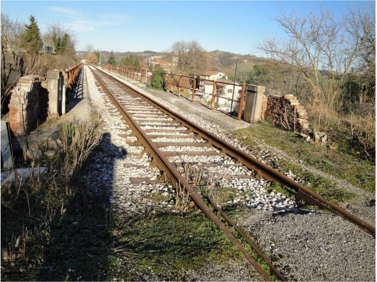
Primo Ponte FS dopo la stazione verso Pergola
