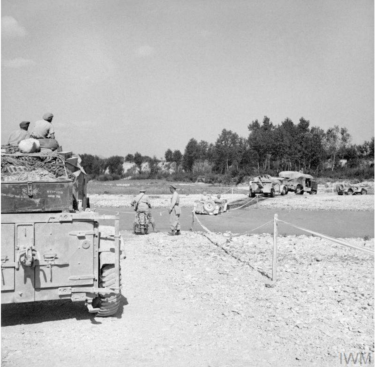
Attraversamento F. Metauro
