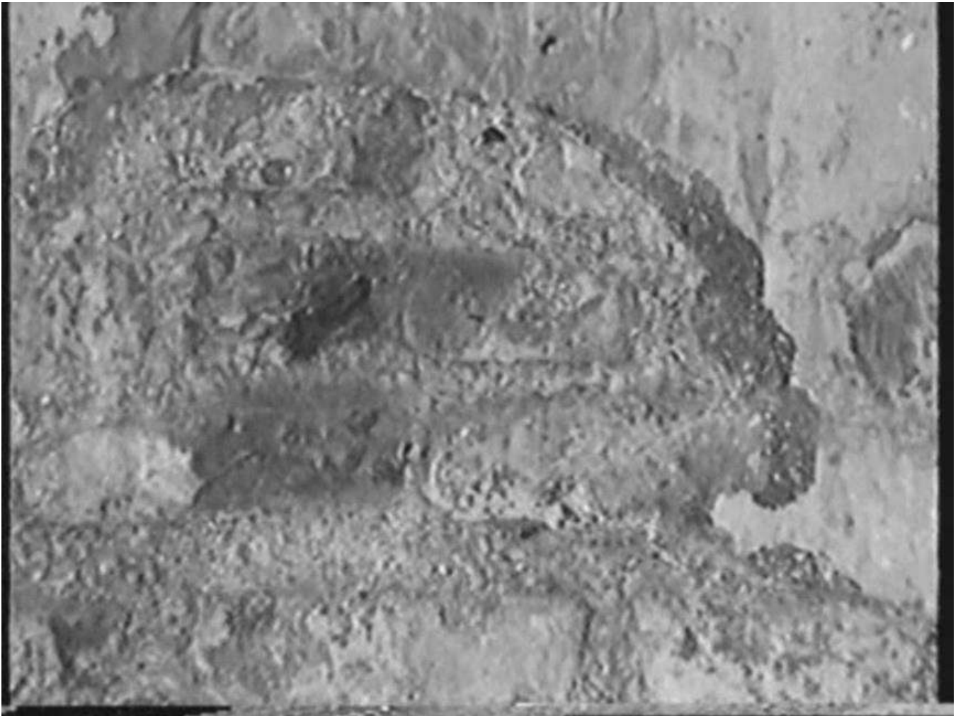
Foto di una pallottola nel muro interno della loggia
