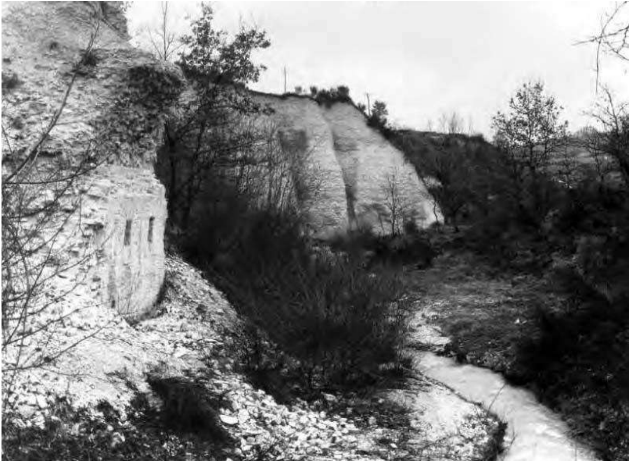
Ruderi del ponte di Chigiano
