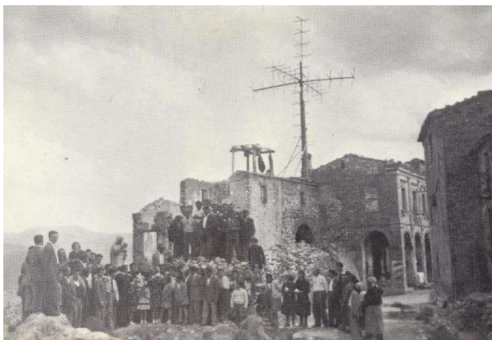
Chiesa di S. Donato distrutta
