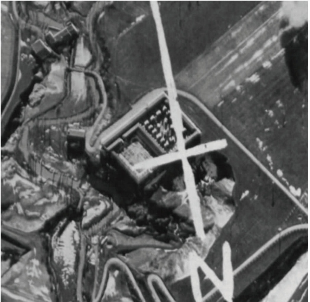
Particolare area Cimitero le Cortine vicino la stazione FS
