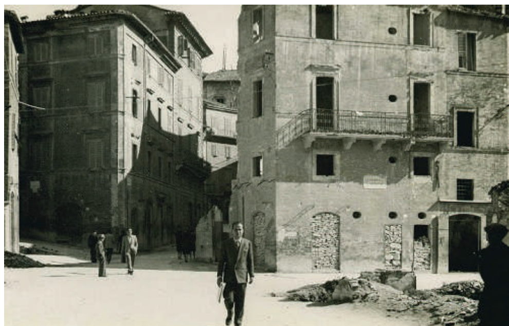
Via Cialdini con Piazza Garibaldi dopo il bombardamento
