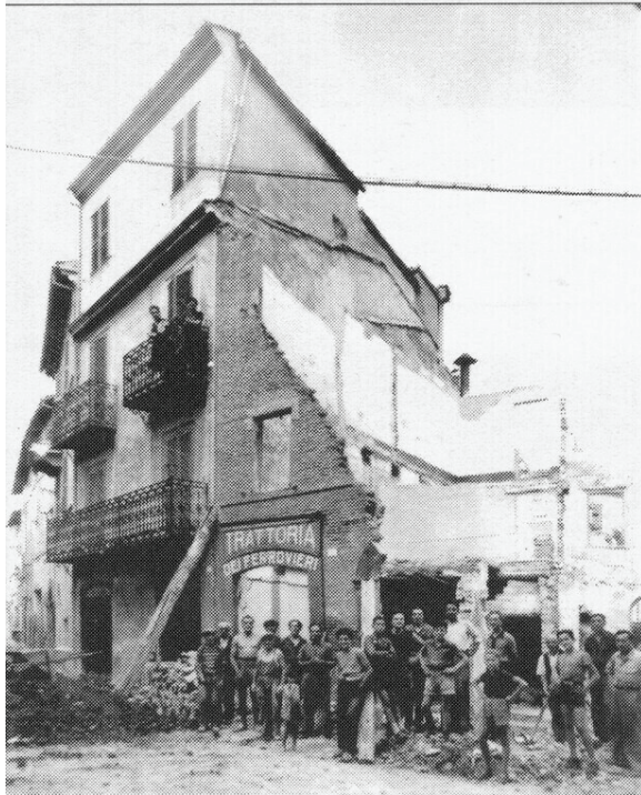
Case inizio Via Gioia con Via Cialdini dopo il bombardamento
